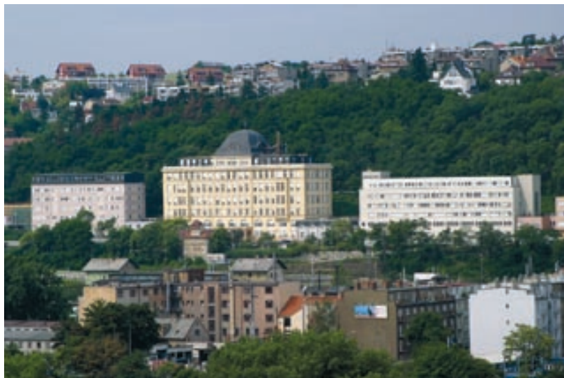
Nynější pohled na ústředí ČSSZ v Praze
